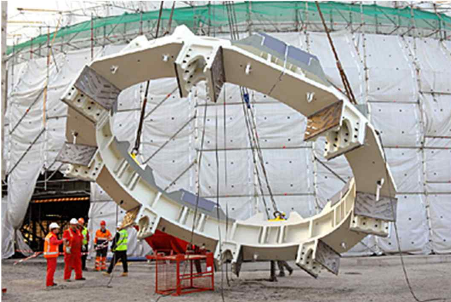
RPV Support 설치
